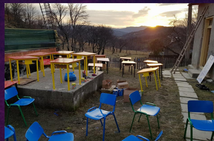
Măgura 2017 renovarea școlii
